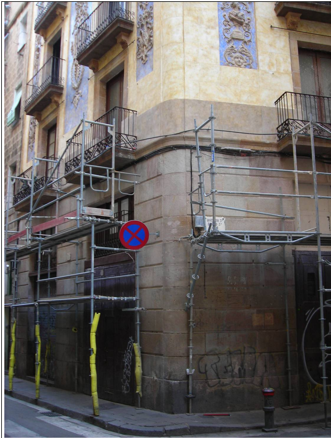
Foto núm. 1: Vista general de l'edifici al carrer sant Gil, cantonada amb el carrer de Sant Vicenç
