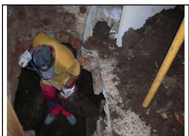
Excavació del nivell UE 9
