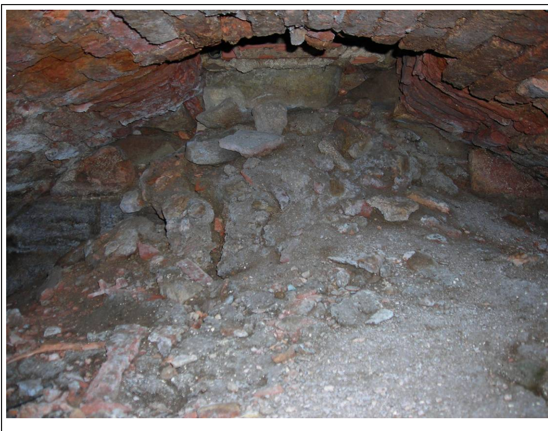
Foto núm. 18: Vista interior del dipòsit annex
