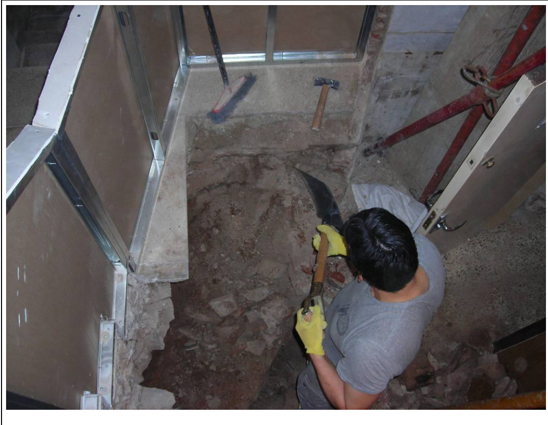
Foto núm. 4: Treballs d'excavació de les UE 4 i UE 5
