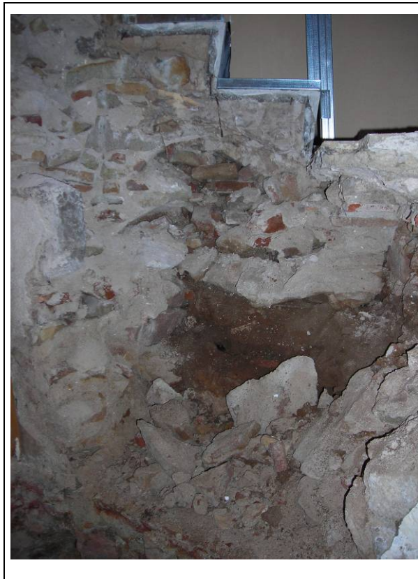
Foto núm. 5: Vista de l'alçat a la banda de les escales
