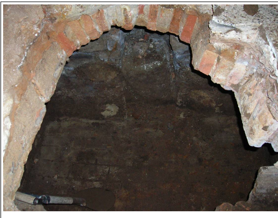
Foto núm. 9: Volta de maons UE 7, del dipòsit UE 10
