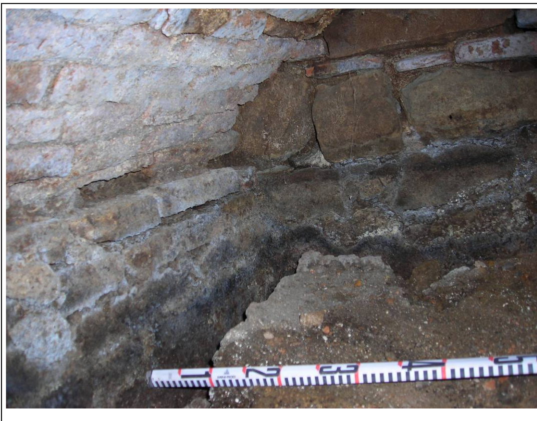
Foto núm. 10: Vista interior de la vola UE 7
