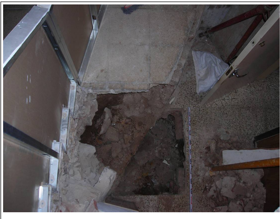
Foto núm. 3: Treballs d'excavació, extracció de les UE 1, UE 2 i UE 4
