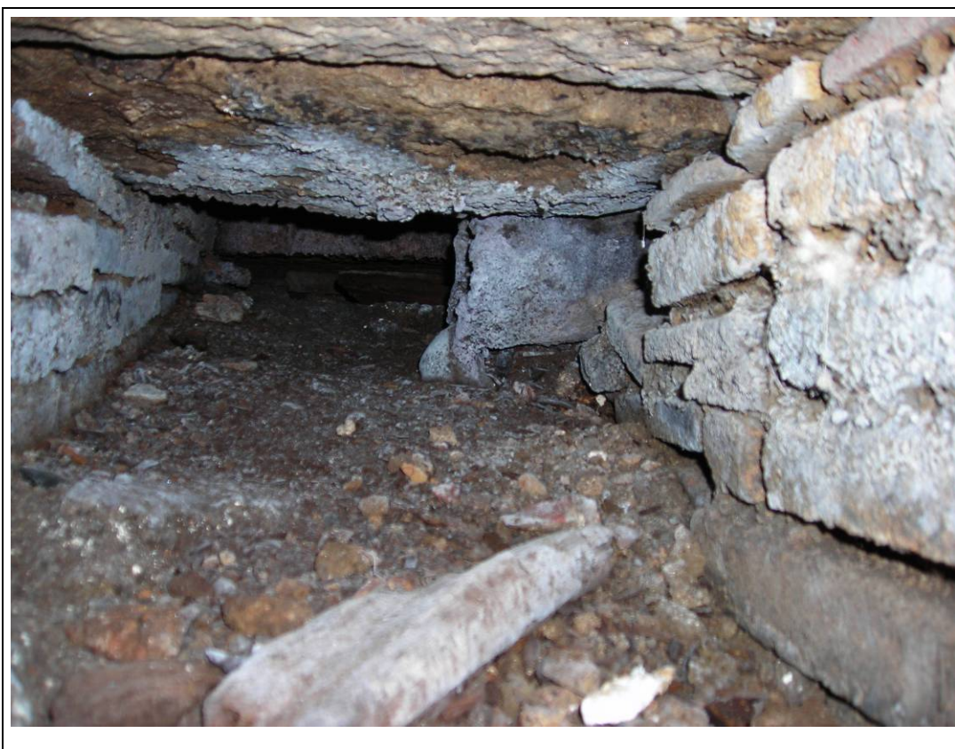
Foto núm. 20: Claveguera UE 12, vista interior
