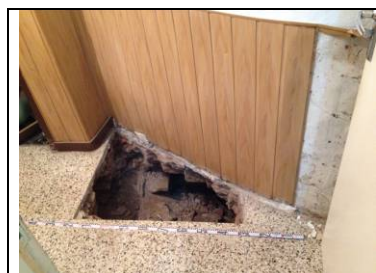
Àrea on va ubicat l'ascensor, envà UE 3
