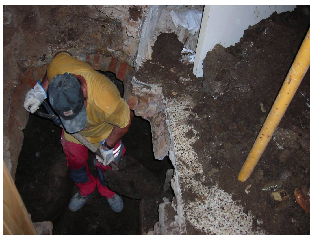
Foto núm. 7: Treballs d'excavació de les UE 9
